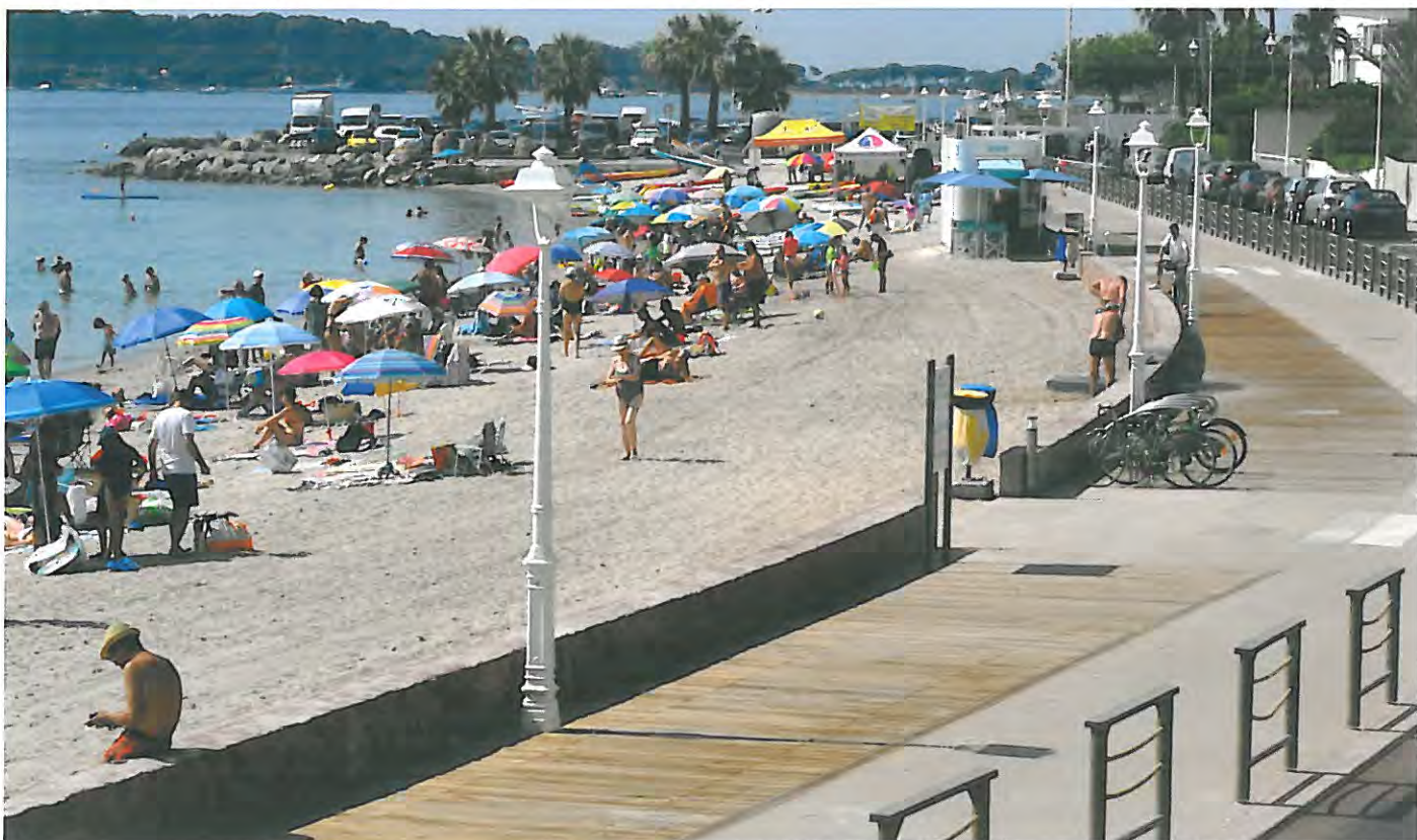
Le boulevard Eugène-Gazagnaire rénové. Derrière les barrières amovibles, la piste cyclable « réversible » et le cheminement piéton en platelage de bois
